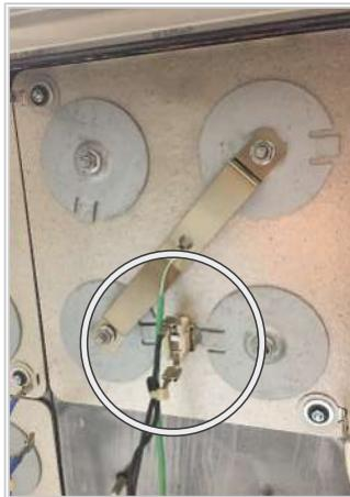
10. 次に、トルクレンチ ( $4^{\circ}\text{Nm}$ ) で4個のナットを対角に締めます。
